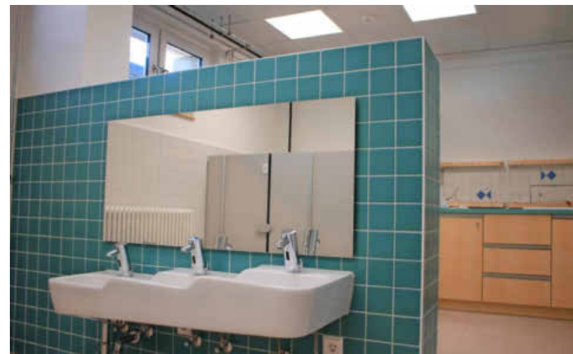
Der Sanitärbereich in Türkis und Grau hat Waschrinnen erhalten. Wo das Personal-WC war, steht nun ein Wickeltisch (im Hintergrund).
