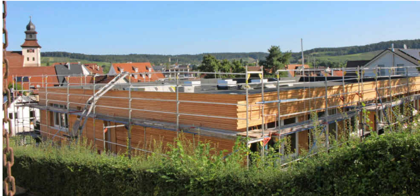
Die tristen Betonteile sind Geschichte. Die neue Holzverschalung wertet den Kindergarten Siebenmorgenweg nach der energetischen Sanierung auf.
